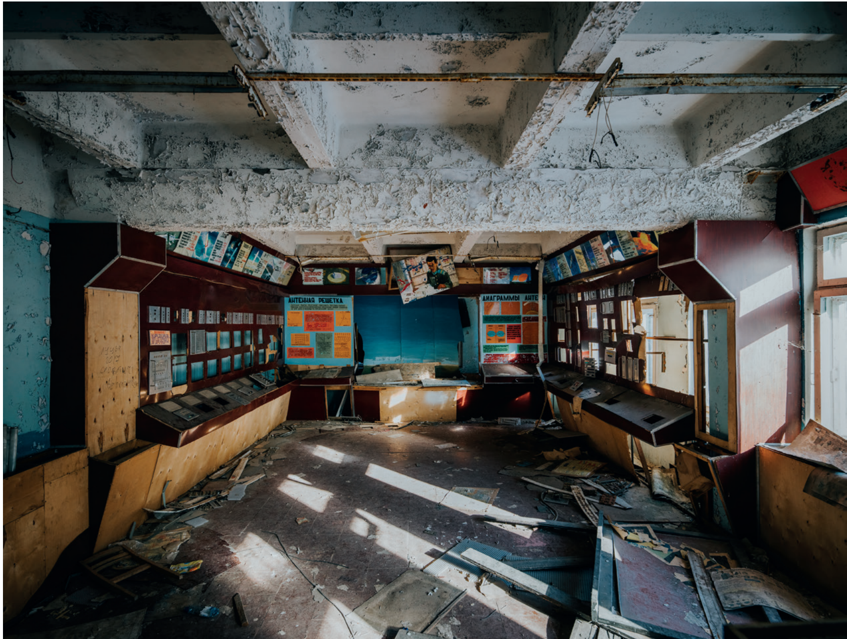
Une des nombreuses salles de contrôle du Radar de Duga-1.
