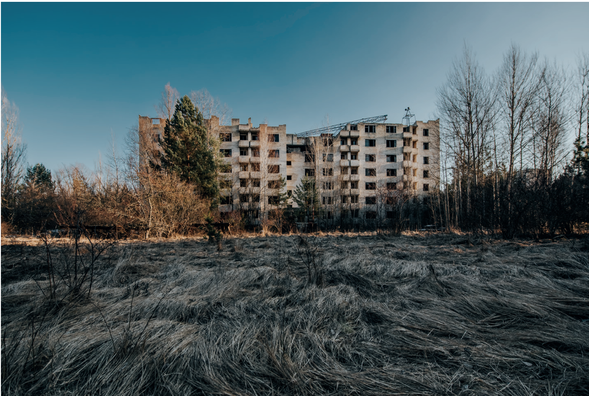
Immeuble en construction à Prypiat.
